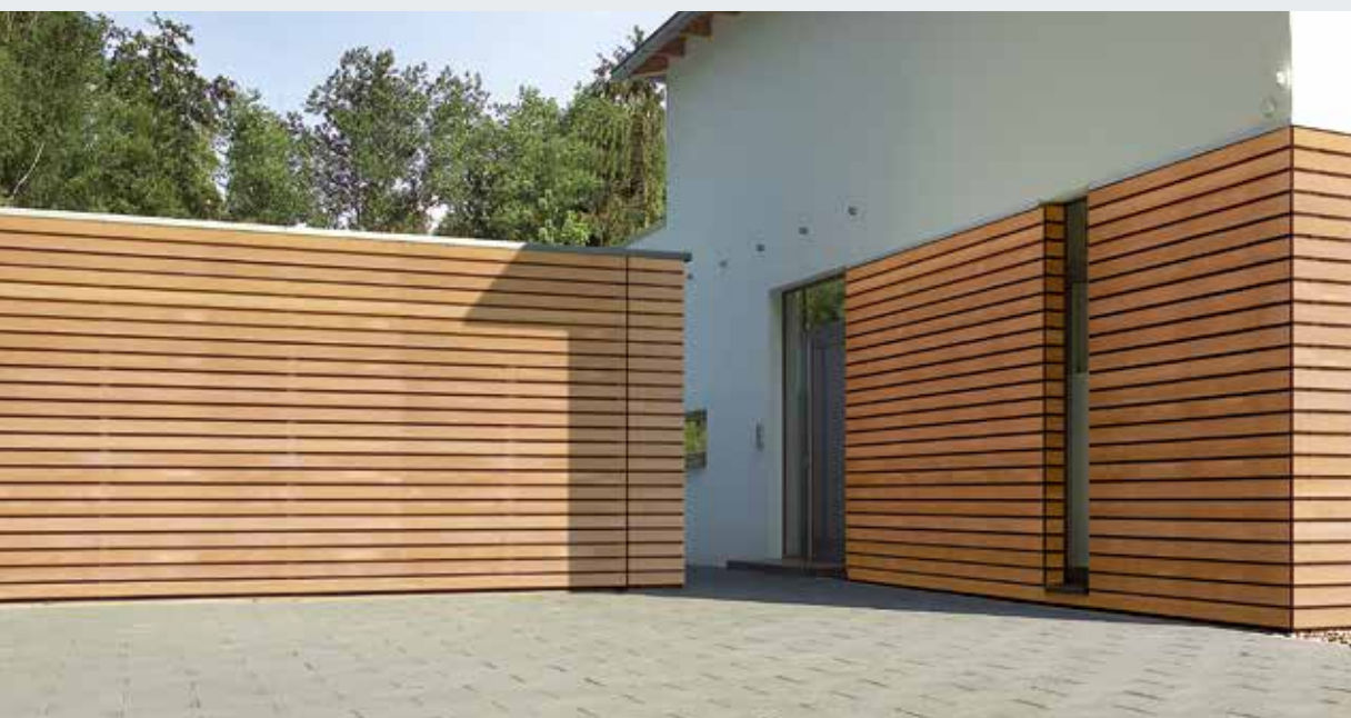
Облицовка деревянными панелями, выполняемая заказчиком
